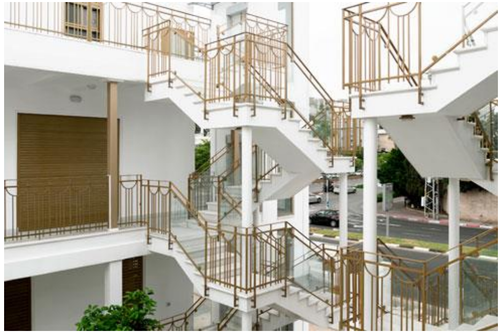
בניין של פורטוגלי בצפון ת"א. אגפי המלון של סבתא מדגימים את גישתה של הנכדה, לעתיד לבוא (צילום: גדעון לוי)
